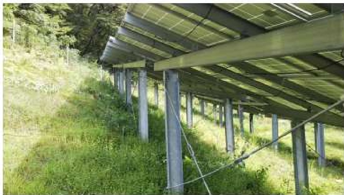
図1.9-1 杭基礎の設置状況写真（例）
