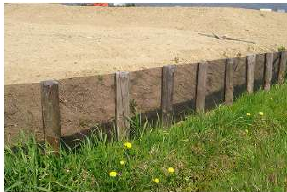
図 1.9-3 FRP ネット柵の設置状況写真（例）
