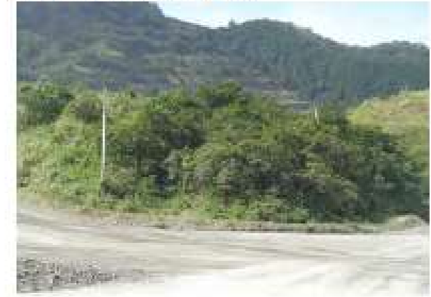
⑱ 植栽緑地(中央盛土部)
