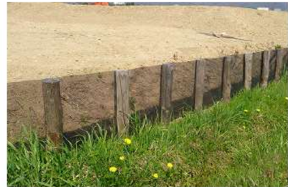
図 1.9-4 FRP ネット柵の設置状況写真（例）
