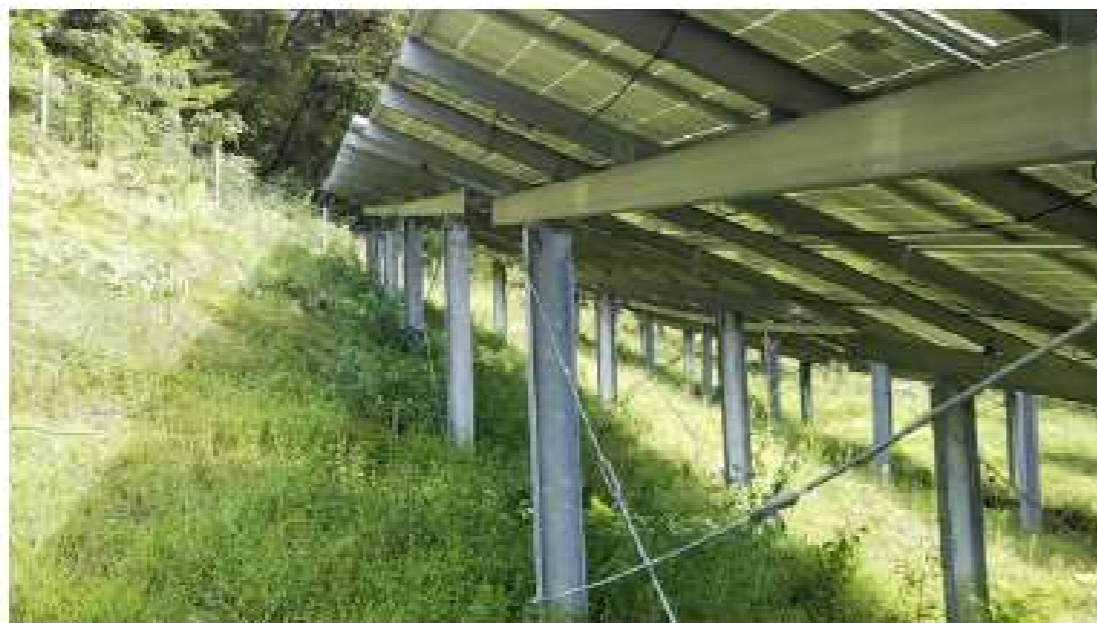
図1.9-2 杭基礎の設置状況写真（例）
