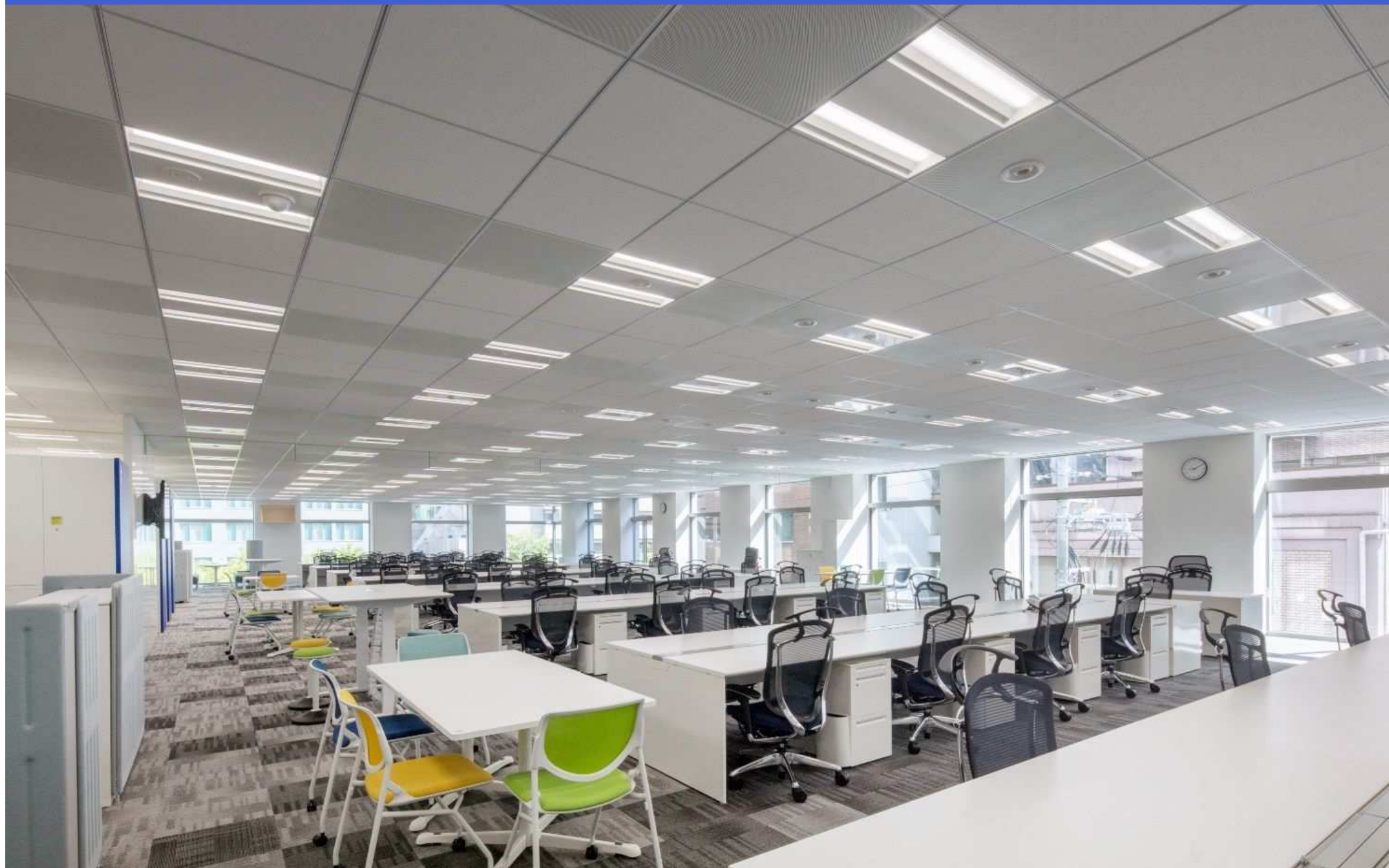
人感+明るさセンサー制御により、机上面500lxに制御
