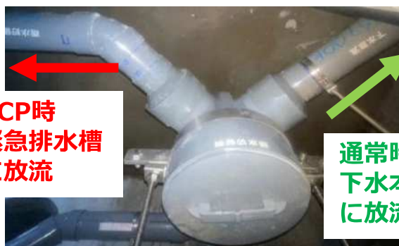
1階系統排水の切替枴
