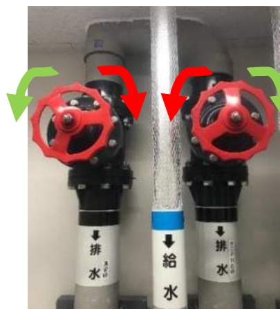
2階以上系統排水の切替バルブ
