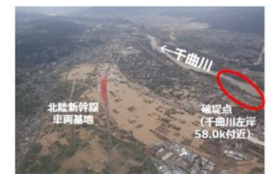
令和元年台風第19号による洪水被害 (信濃川水系千曲川 (長野県長野市))
