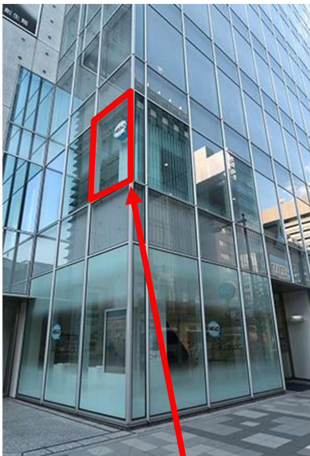
アタッチ施工場所
