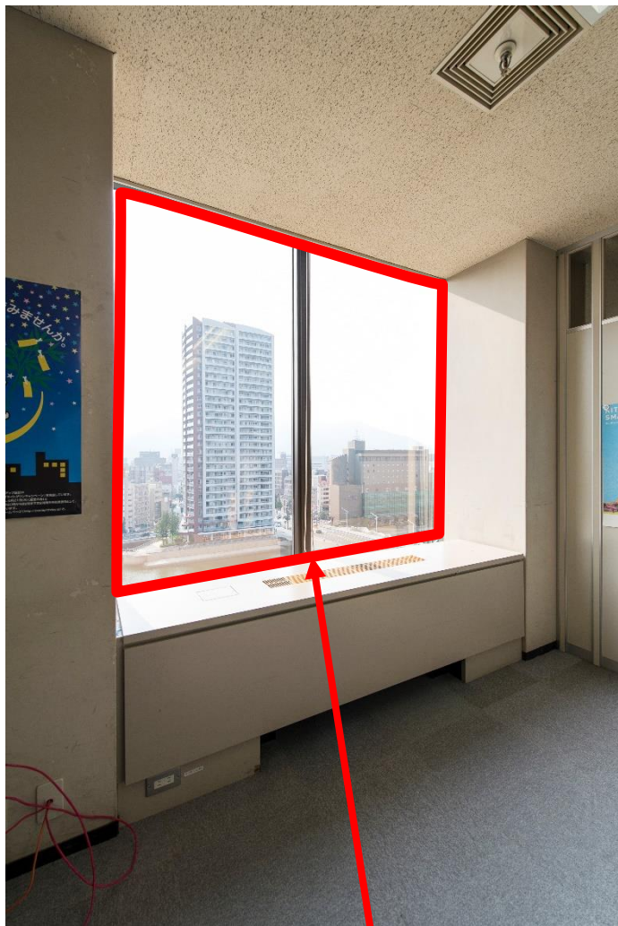
アタッチ施工場所
