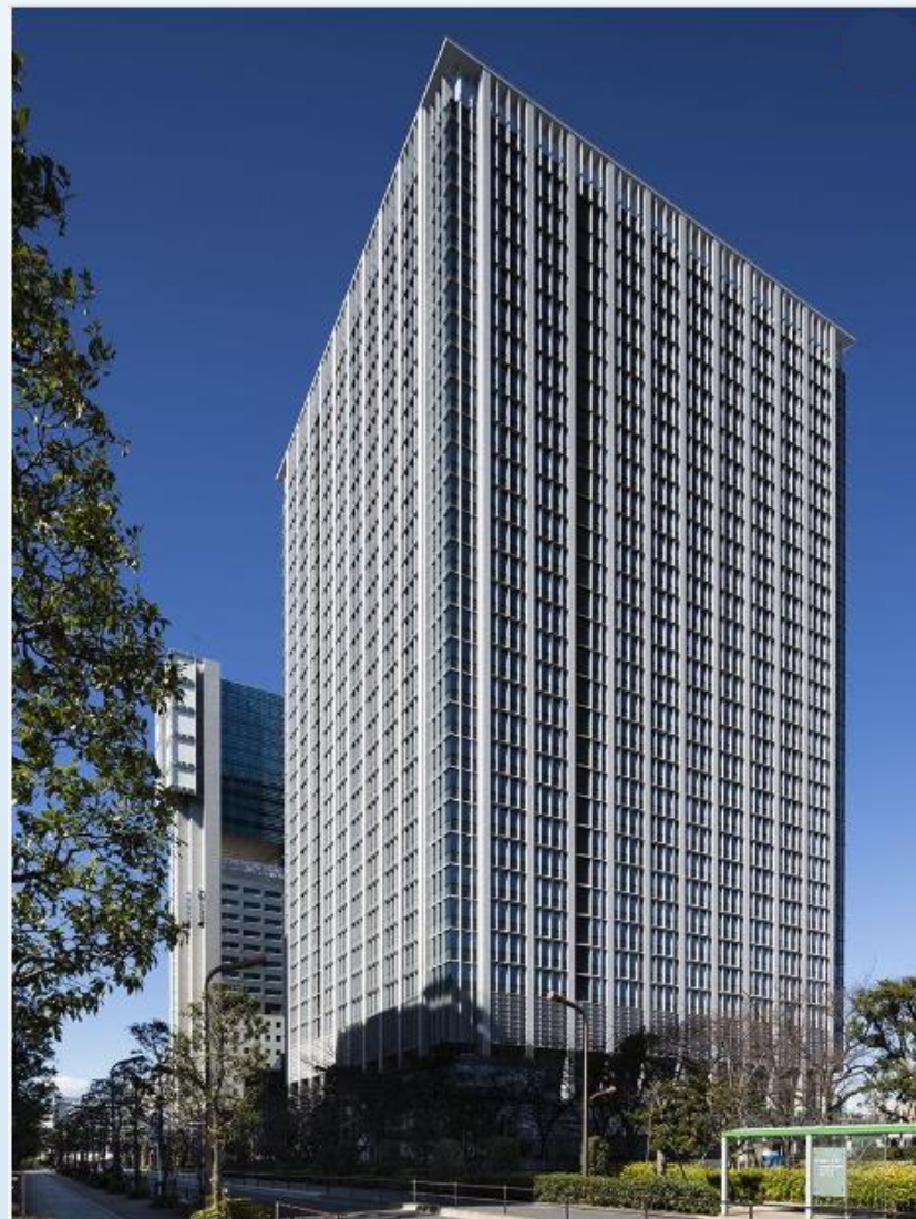
ビル南側より
