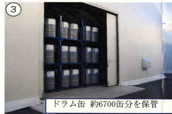
汚染土壤一時保管施設 (大田区城南島)
