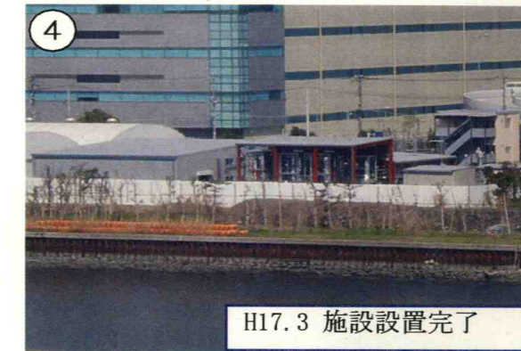
土壤浄化施設全景 (大田区東海二丁目)
