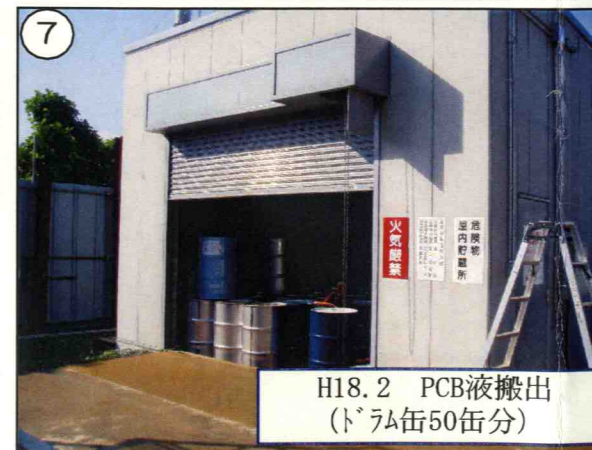
PCB液保管庫 (土壤浄化施設内)
