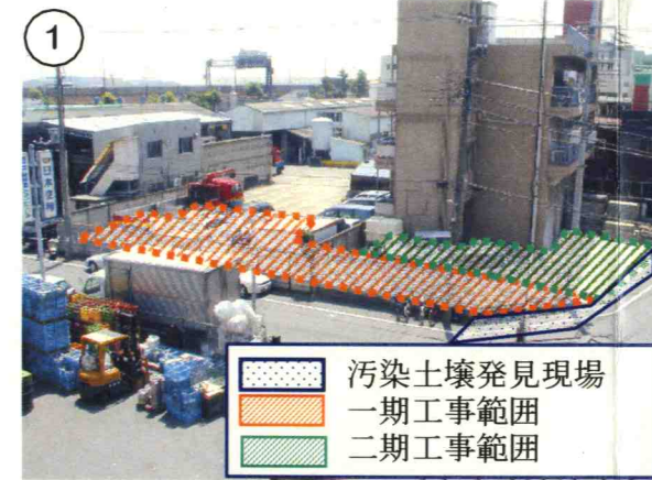
汚染土壤発見現場 (大田区大森南四丁目)
