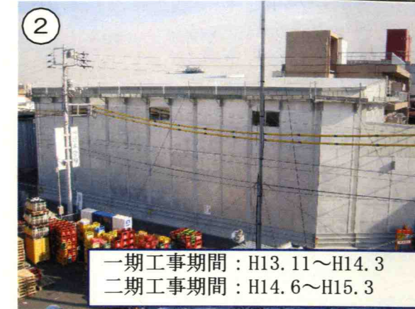
汚染土壤掘削除去工事
