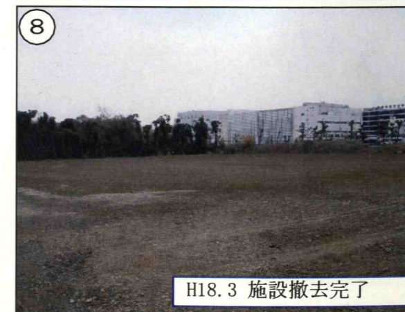
土壤浄化施設撤去完了
