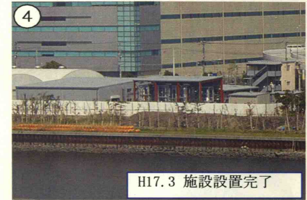
土壤浄化施設全景（大田区東海二丁目）
