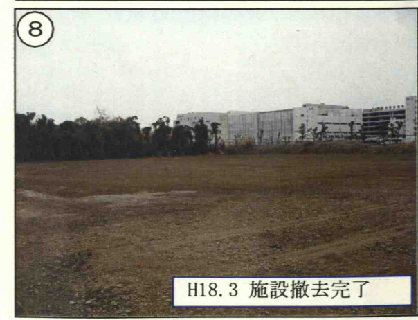
土壤浄化施設撤去完了
