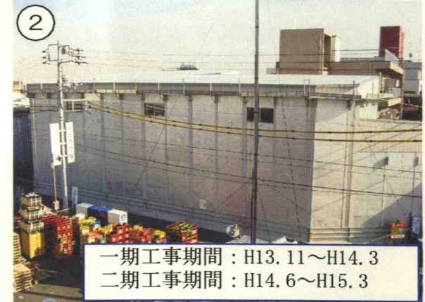
汚染土壤掘削除去工事
