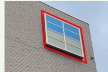
＜建材一体型太陽光発電設備（奥多摩水と緑のふれあい館設置状況）＞
