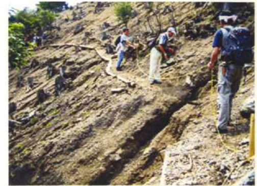
写真：斜面の崩壊
