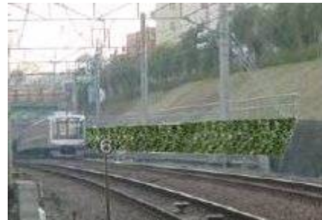
線路敷地法面の緑化 (東急東横線)
