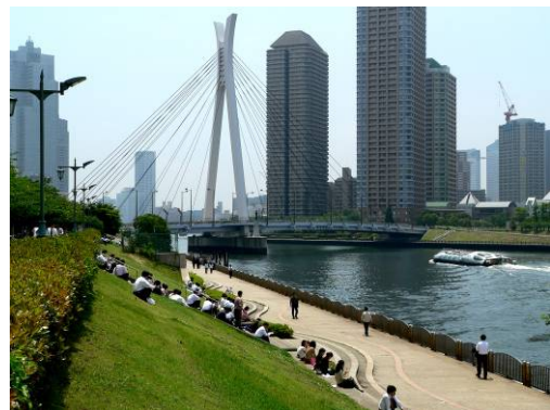
隅田川スーパー堤防（中央区）
