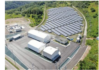
水素製造研究施設 （山梨県甲府市）の外観
