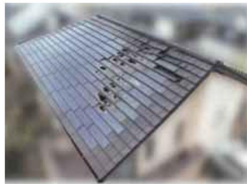
屋根の被災状況（右はモジュール撤去後）
