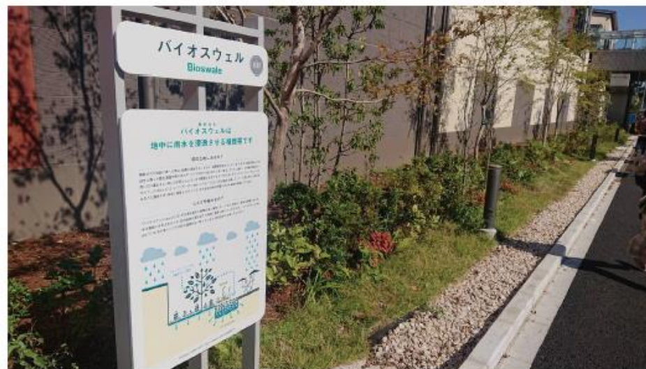
雨水浸透機能を活用した商業施設 (出典：南町田拠点創出まちづくりプロジェクト)
