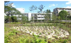
周囲に降った雨水を集めて地下に浸透させるレインガーデン (世田谷区立上用賀公園)
