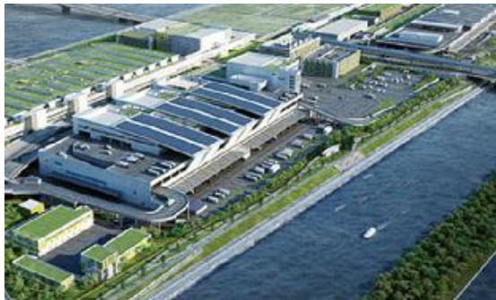
導入例：豊洲市場 発電容量：2,000kW
