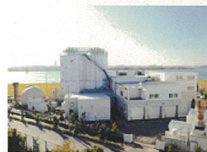
【スーパーエコタウンにおけるバイオガス発電】
