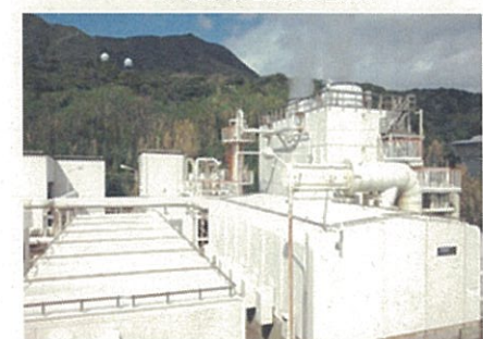
【八丈島地熱発電所】
