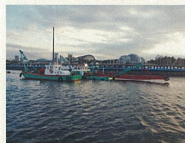
【ポンプしゅんせつ船(砂町運河)】
