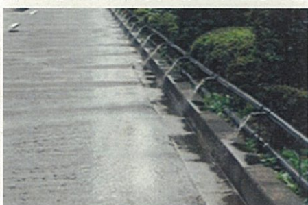
【保水性舗装・散水設備】
