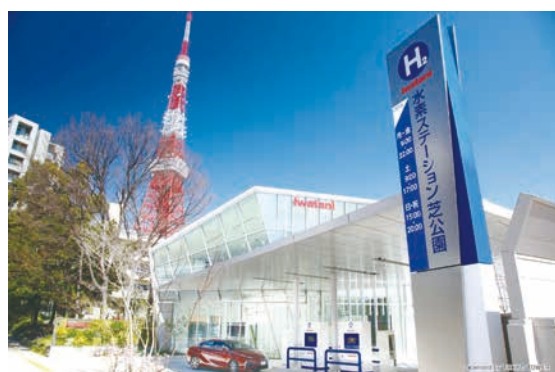
水素ステーション
