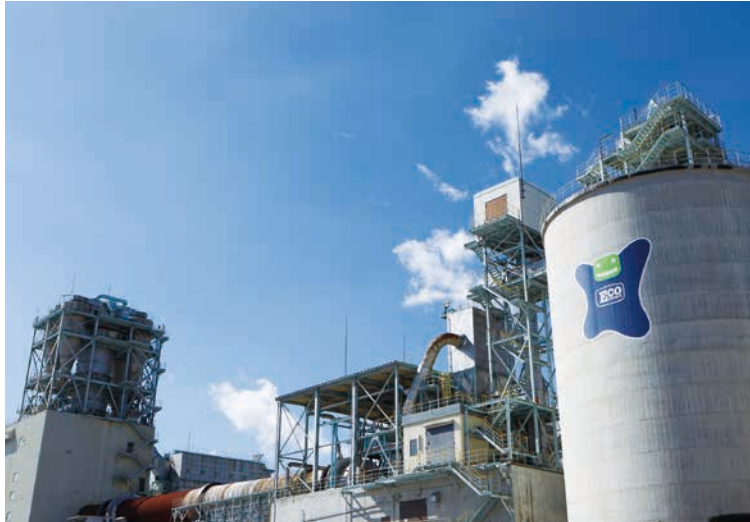
エコセメントプラント
