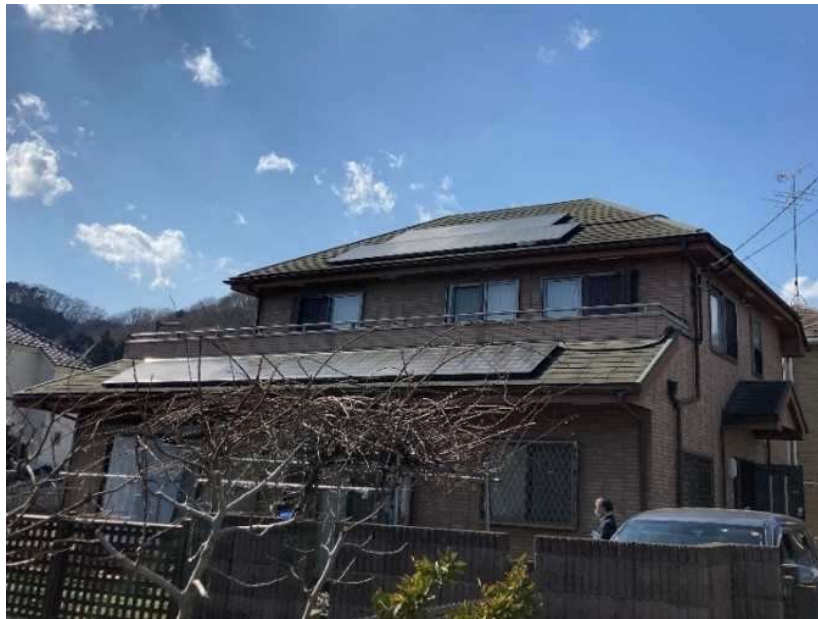
調査対象建物外観
