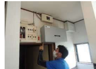
屋内設備の確認
