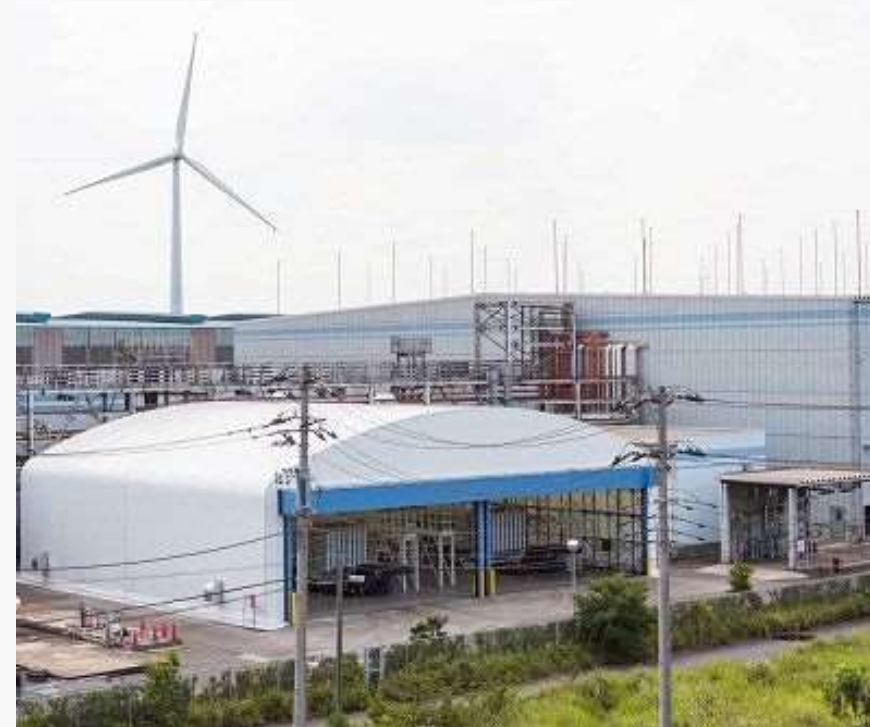
川崎リサイクルセンター外観
