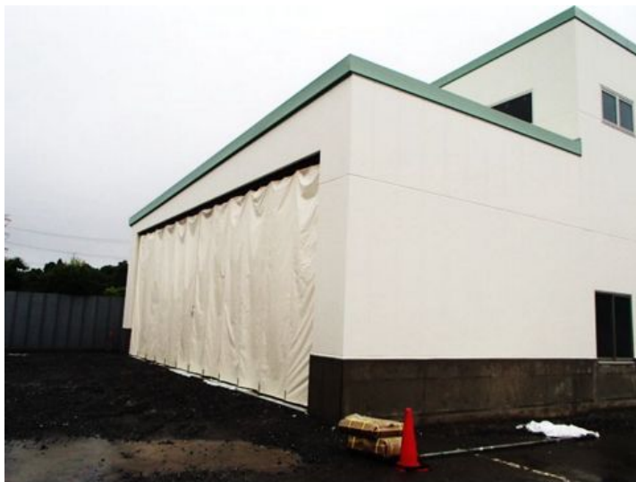
製品保管棟(左側)
