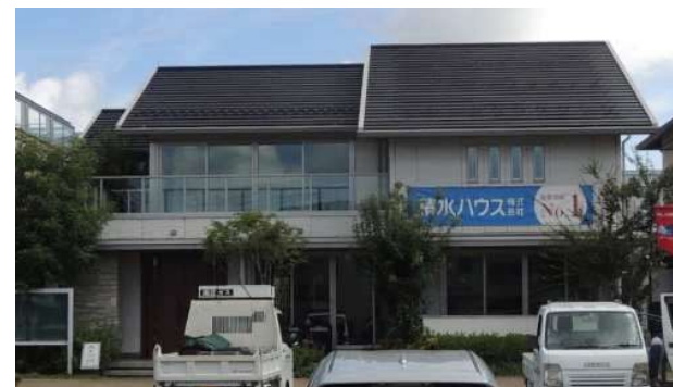
対象建物外観
