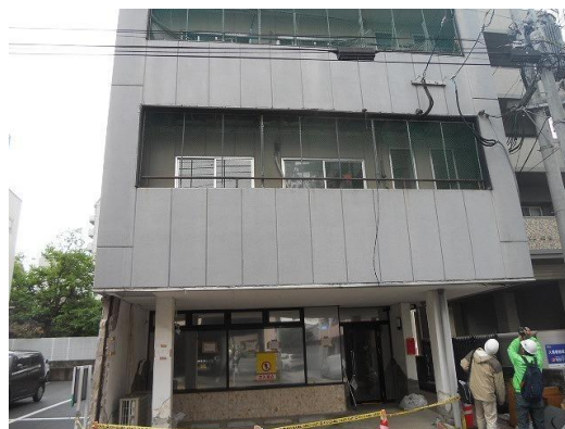
損壊建築物の調査（全体確認）
