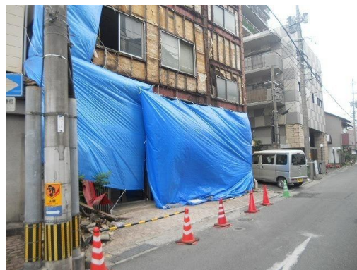
シート養生及び立入禁止措置の例
