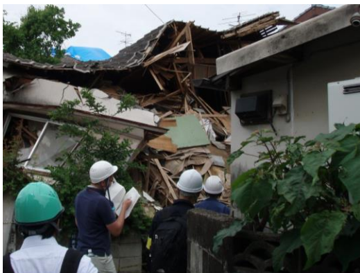
倒壊建築物の調査
