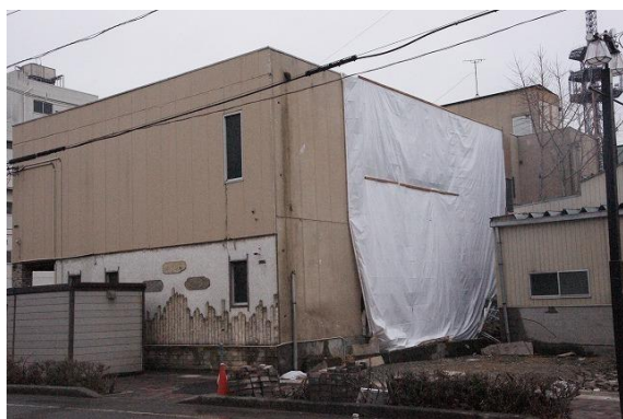
シートによる養生例
