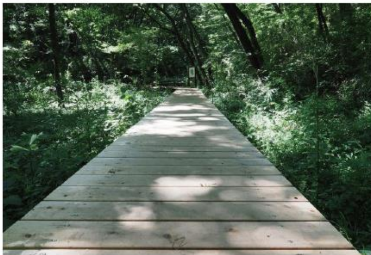
多摩産材を活用した都立小宮公園の木道 (出典：多摩産材情報センター)
