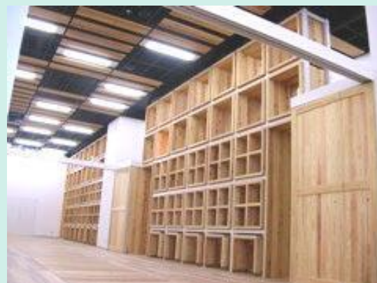
間伐材を使用したエコプラザの内装
