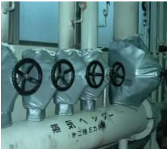
蒸気弁の保温施工例 (着脱式保温カバー)
