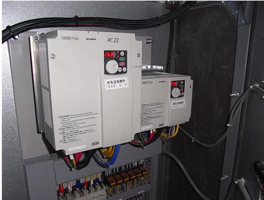
インバータ本体 (インバータ盤内部)
