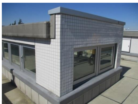
[自然換気システム]
