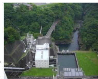
多摩川第一発電所
