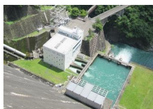
多摩川第一発電所
