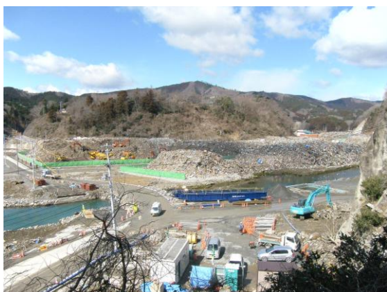
東日本大震災廃棄物（女川町仮置場の様子）
