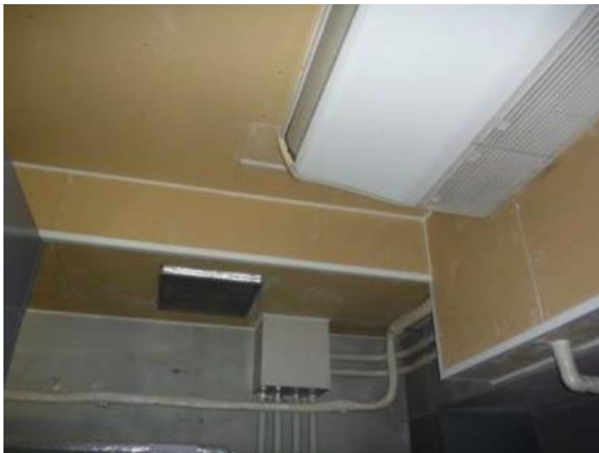
写真 19 囲い込み施工例
