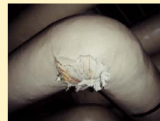
アスベスト保温材 (配管の断熱被覆)
