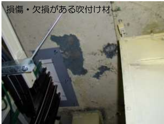
劣化した吹付け材の例
