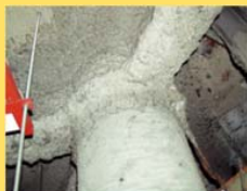
吹付け石綿 (鉄骨材の耐火被覆)
