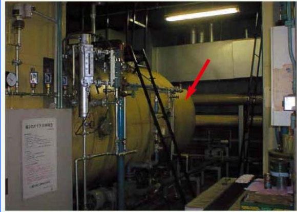
石綿含有保温材（ボイラ外周部）
