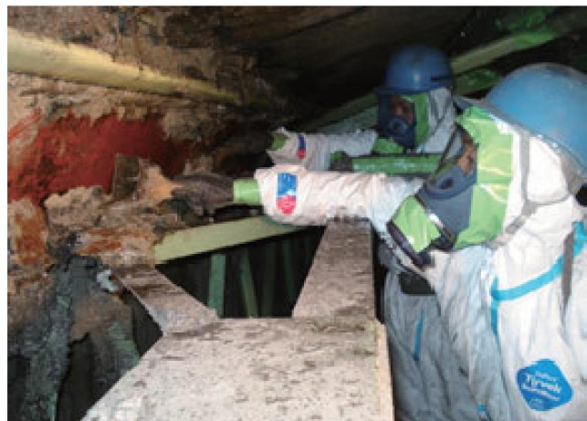
写真 17 石綿の除去作業 16)
