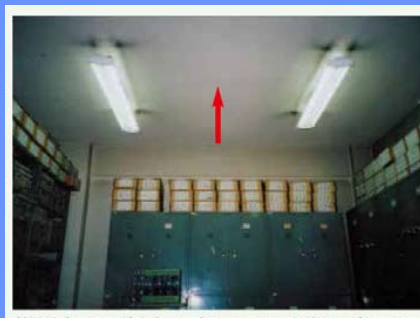
結露防止用の石綿含有パーミキュライト吹付け・パーライト吹付け（天井・壁等）
