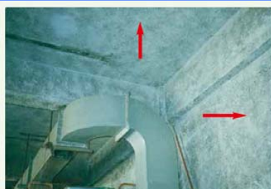
吸音用吹付け石綿・石綿含有吹付けロックウール（天井・壁等）
