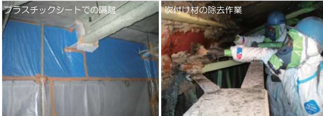
除去工法の施工例
