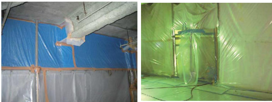
写真 15, 16 プラスチックシートによる隔離例 16)
