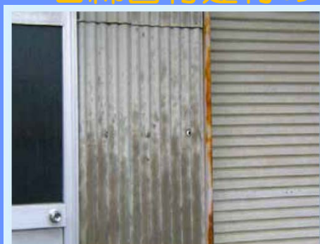
石綿スレート（屋根・外壁）
