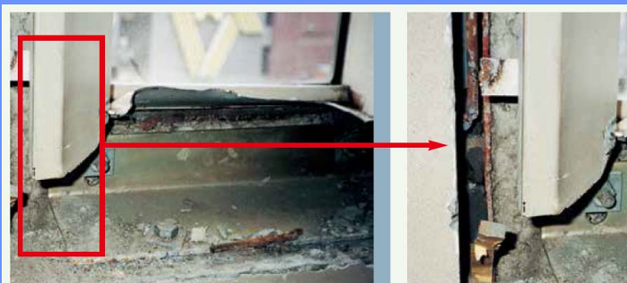
結露防止用吹付け石綿・石綿含有吹付けロックウール（カーテンウォール裏等）
