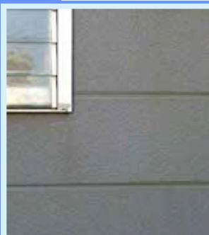
石綿板（窯業系サイディング）
