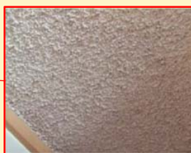
吹付けパーミキュライト (天井の断熱・吸音)
