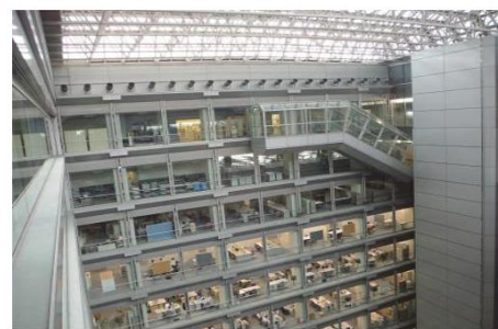
自然採光を利用した低層アトリウム
